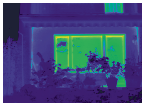
Po svědomitém zabudování nových oken Corona CT 70 dokazuje Thermografie vysoký energetický užitek investice. Původní ztrátě energie je plnohodnotně zamezeno.
